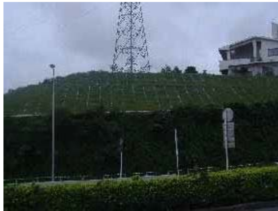
施工完了1ヶ月
